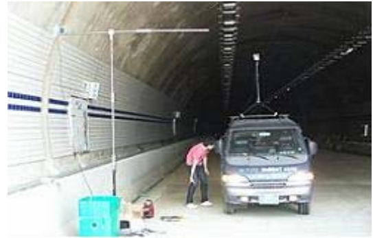
그림 14. 실제 터널 환경에서의 전파전파 특성 측정 Fig. 14. Measurement of wave-propagation characteristics in the actual tunnel.
