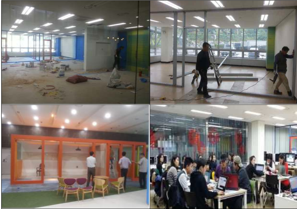
[그림 15] 대전 창업공작소 리모델링 작업
